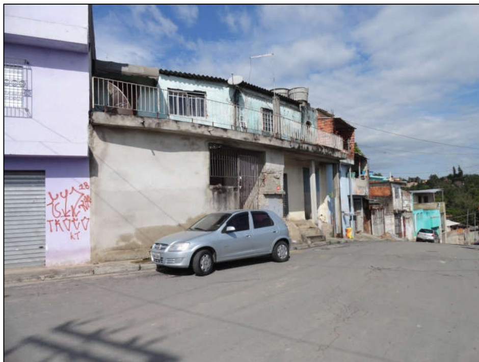
Foto FC-ITA-04-08.01: Vista do setor com rua asfaltada e moradias em alvenaria.
