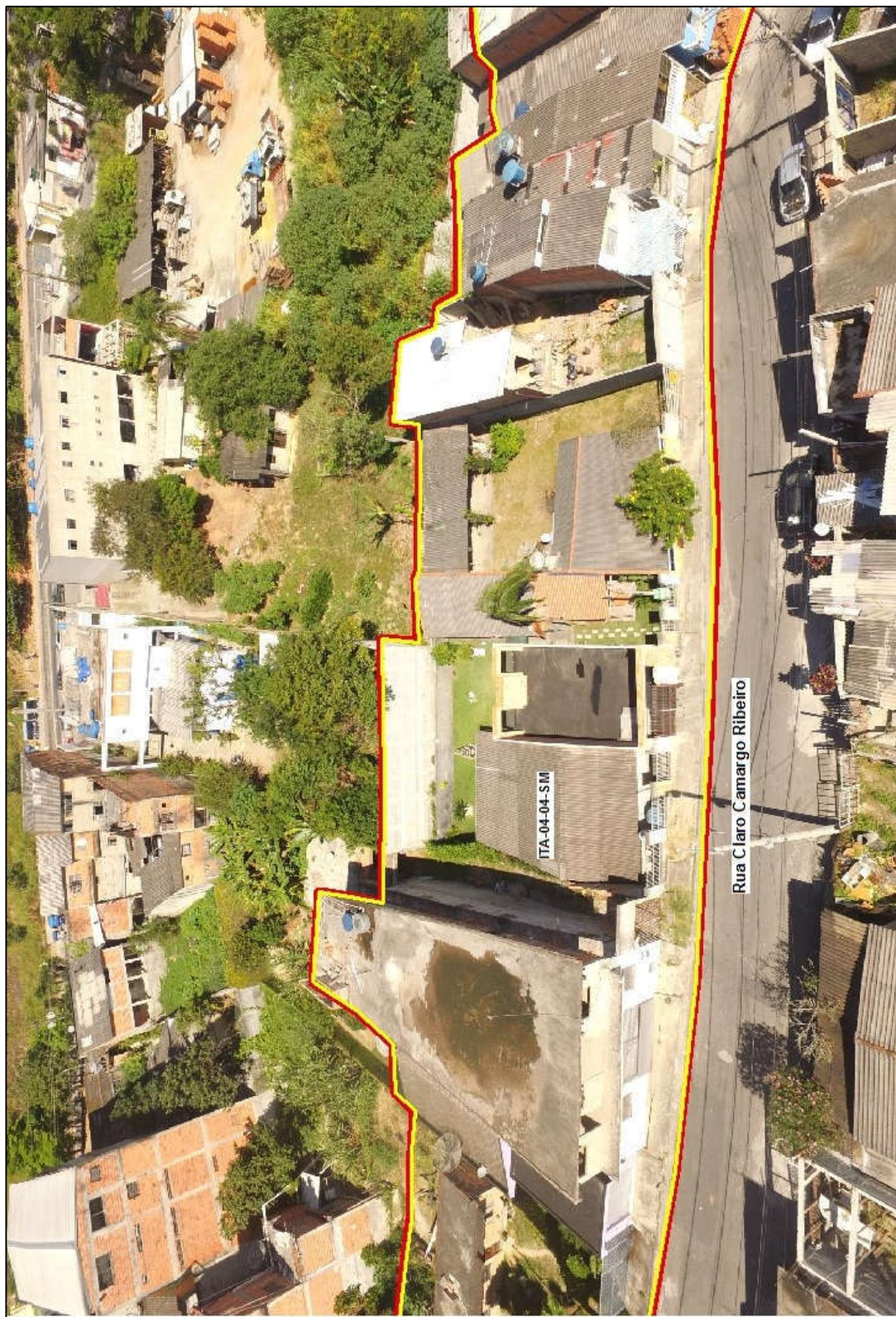
Foto FH-ITA-04-04.02: Vista do setor mapeado.
