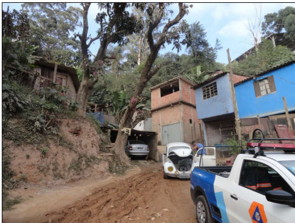
Foto FC-ITA-04-02-04.01: Vista do trecho inferior do setor com moradias de médio a bom padrão construtivo mostrando alguns taludes de corte.
