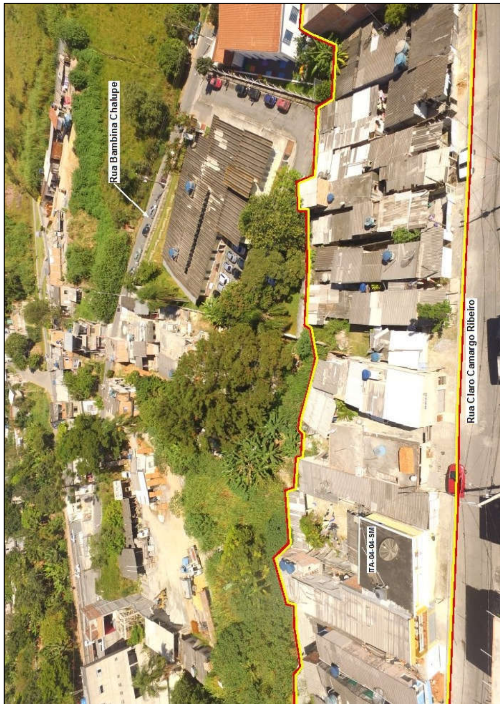
Foto FH-ITA-04-04.03: Vista do setor mapeado.
