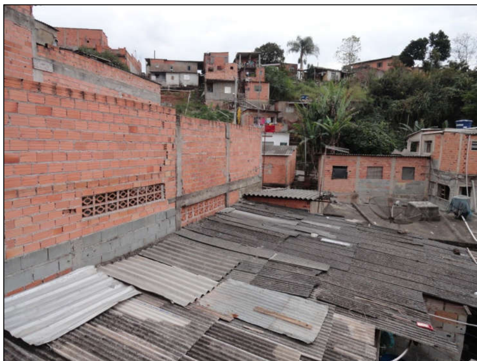
Foto FC-ITA-04-05.04: Vista do trecho final do setor com alta densidade da ocupação.
