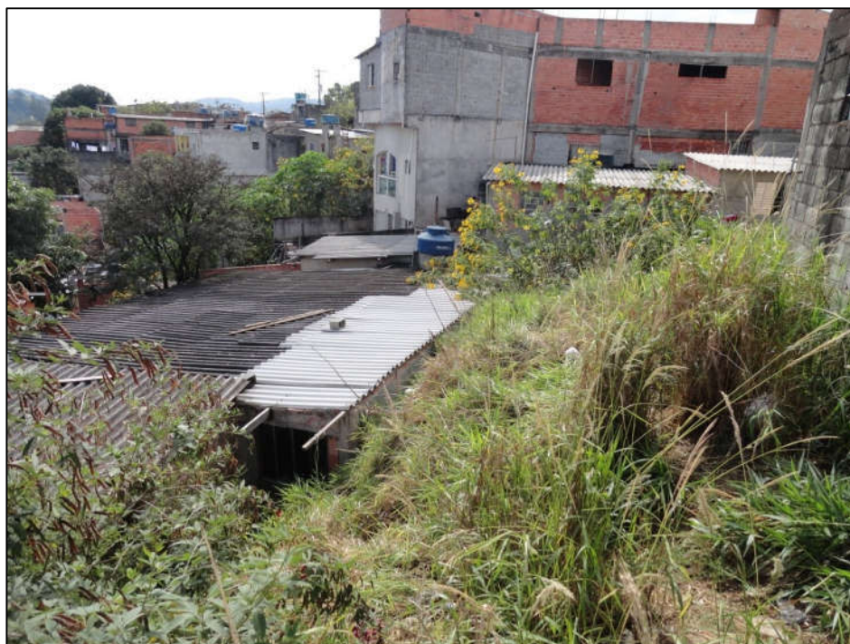
Foto FC-ITA-04-07.03: Trecho do setor com terreno vazio e moradias de alvenaria.
