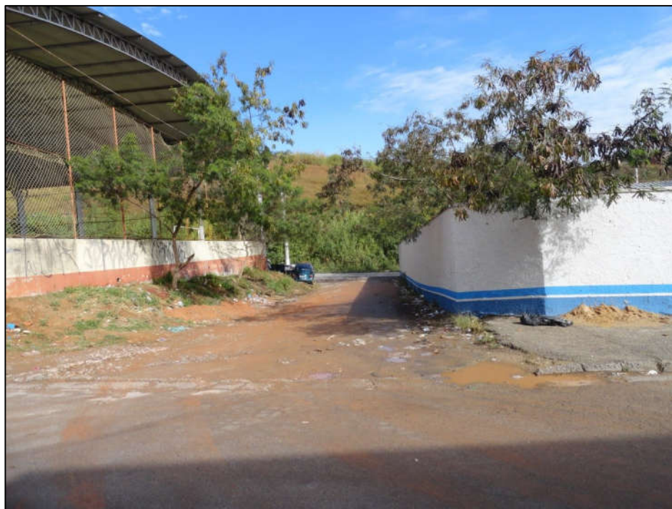
Foto FC-ITA-04-04.01: Vista da quadra de lazer e da escola que estão recobrindo o pequeno córrego.
