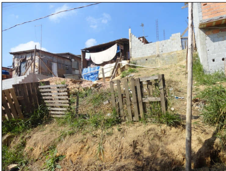
Foto FC-ITA-04-01.06: Terreno vazio com inclinação elevada. Notar moradia sendo construída.
