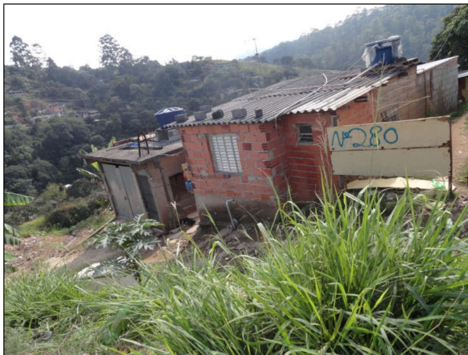
Foto FC-ITA-04-02-01.03: Ocupação de baixa padrão construtivo com terrenos ainda vazios.
