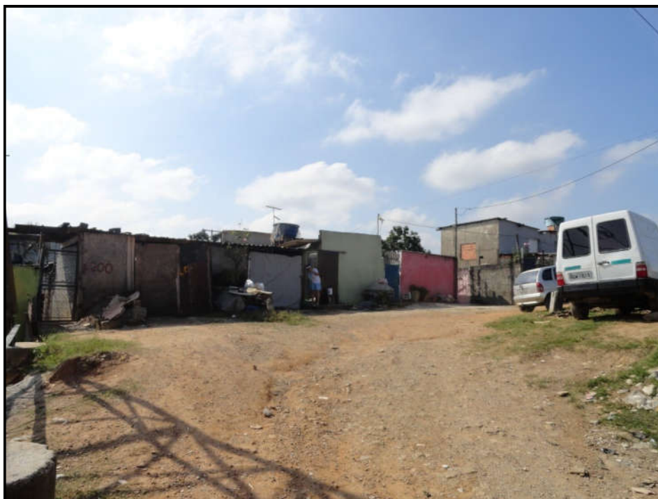
Foto FC-ITA-04-02-01.01: Vista de um trecho do setor no topo da encosta em área mais plana e ocupação de muito baixo padrão construtivo.
