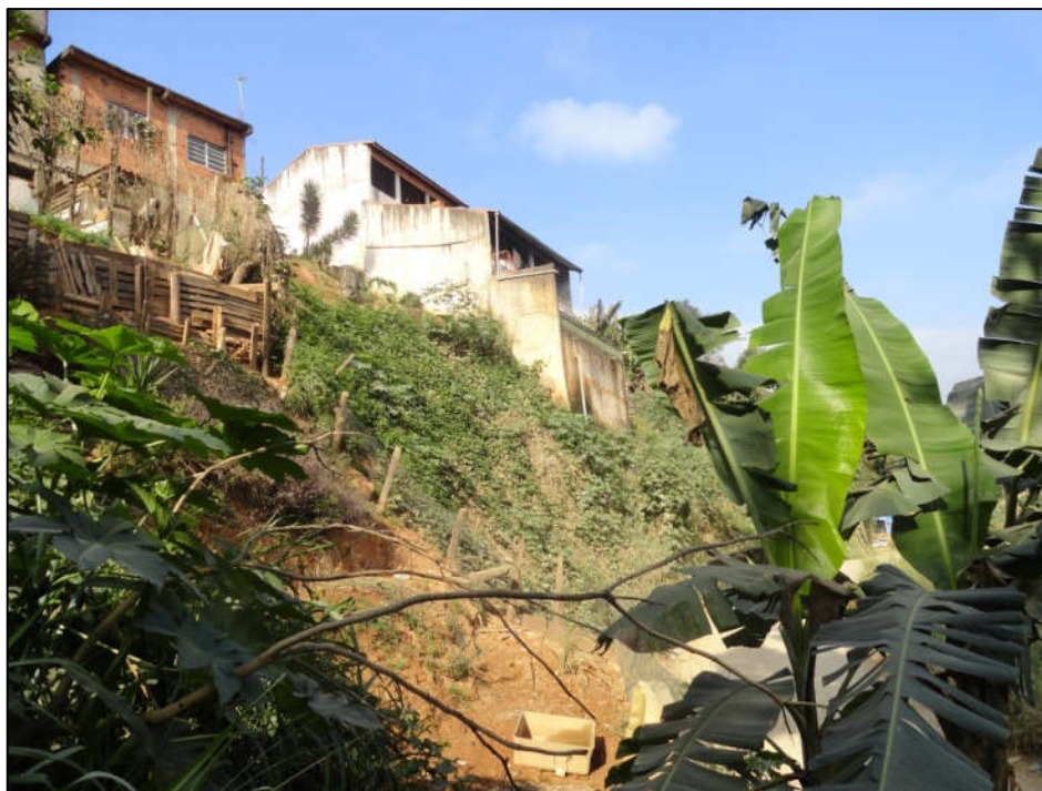
Foto FC-ITA-04-02-02.03: Ocupação no topo do talude de alta inclinação.
