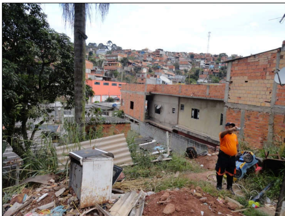
Foto FC-ITA-04-06.04: Detalhe da ocupação na base do talude.
