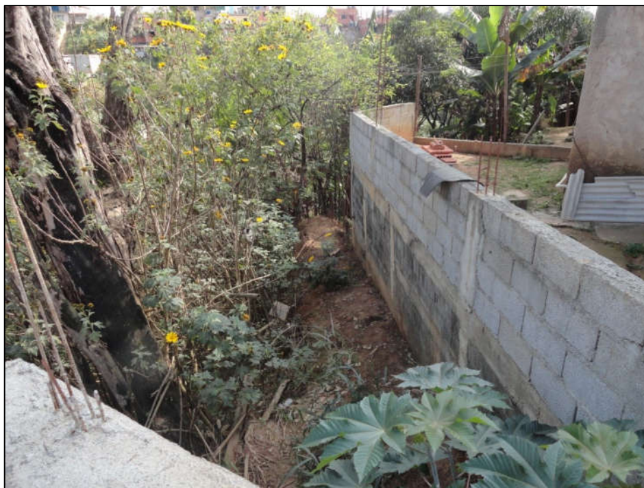
Foto FC-ITA-04-03-01.03: Trecho do setor mostrando muro de contenção construído a meia encosta.
