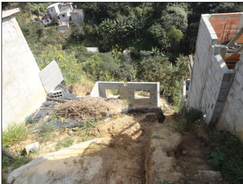
Foto FC-ITA-04-03-01.01: Vista da construção de moradia em talude de alta inclinação.
