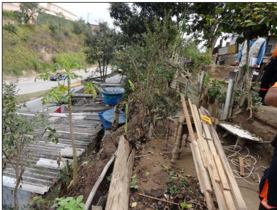
Foto FC-ITA-04-08.03: Trecho do setor com terreno utilizado como horta tendo talude de corte e moradias na base que não estão no setor.
