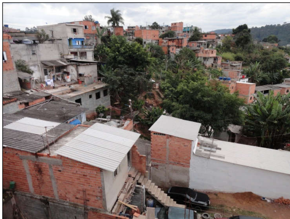
Foto FC-ITA-04-05.02: Vista geral do trecho superior do setor com moradias construídas sobre as nascentes e o pequeno canal de drenagem.
