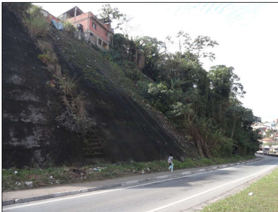
Foto FC-ITA-04-09.03: Vista do setor (parte alta). As moradias do setor estão localizadas depois da obra na encosta.
