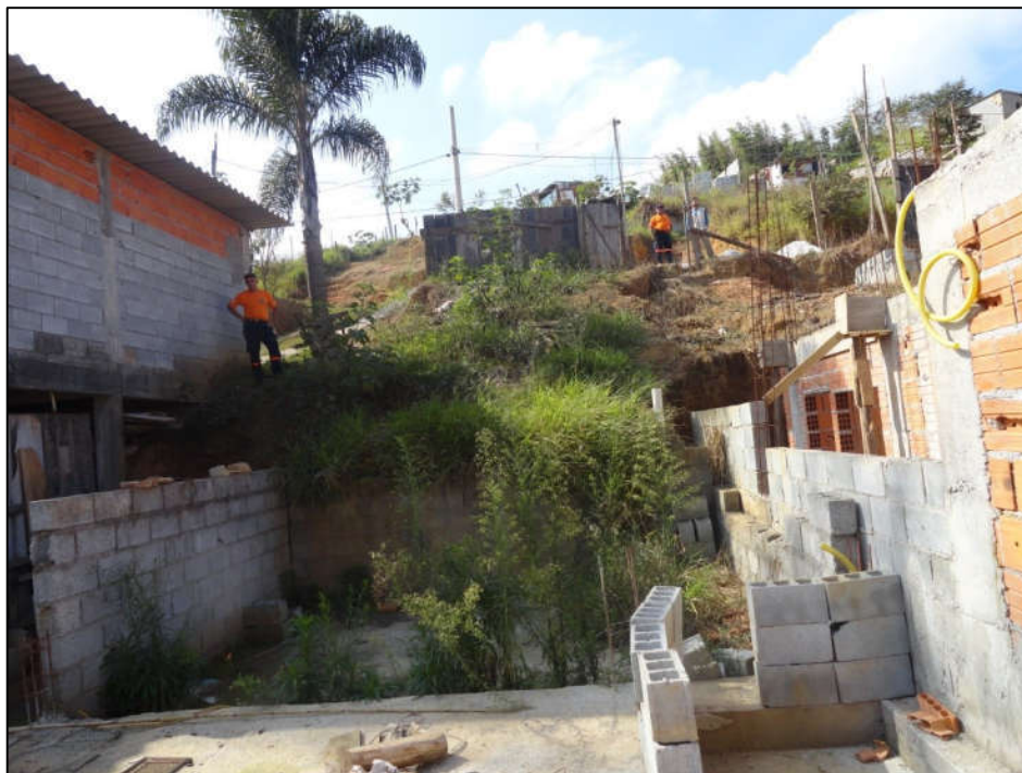
Foto FC-ITA-04-03-01.02: Trecho do setor defronte à Rua Amador Bueno com moradias sendo construídas.
