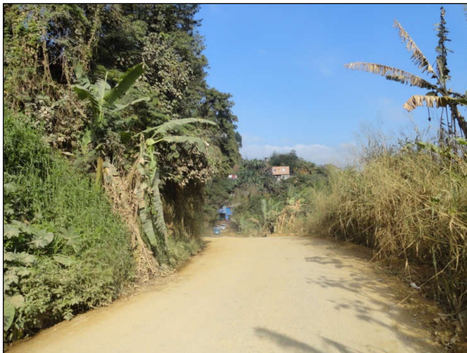
Foto FC-ITA-04-02-03.02: Trecho do setor defronte à Estrada do Prado mostrando a alta inclinação da encosta natural.
