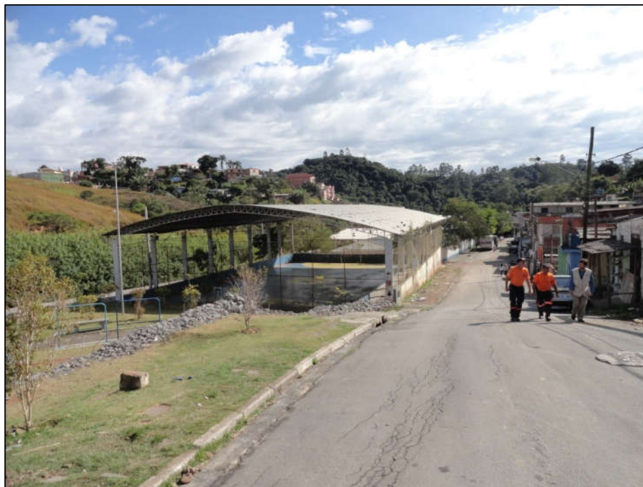
Foto FC-ITA-04-04.02: Vista geral do trecho final do setor com a quadra de lazer recobrindo o córrego.
