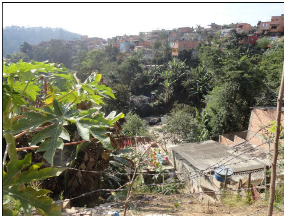
Foto FC-ITA-04-02-04.03: Ocupação próxima ao topo do talude de alta inclinação.
