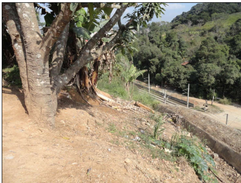
Foto FC-ITA-04-02-01.04: Detalhe da obra da ferrovia.
