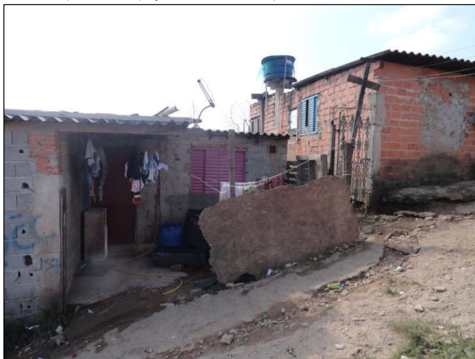
Foto FC-ITA-04-02-01.02: Trecho do setor mostrando moradia de madeira e a inclinação da encosta natural.
