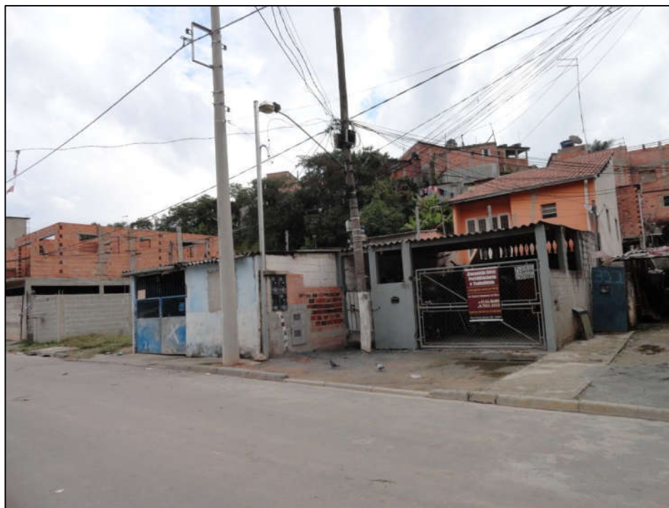
Foto FC-ITA-04-06.01: Vista do setor com trecho plano à frente e talude de corte nos fundos.
